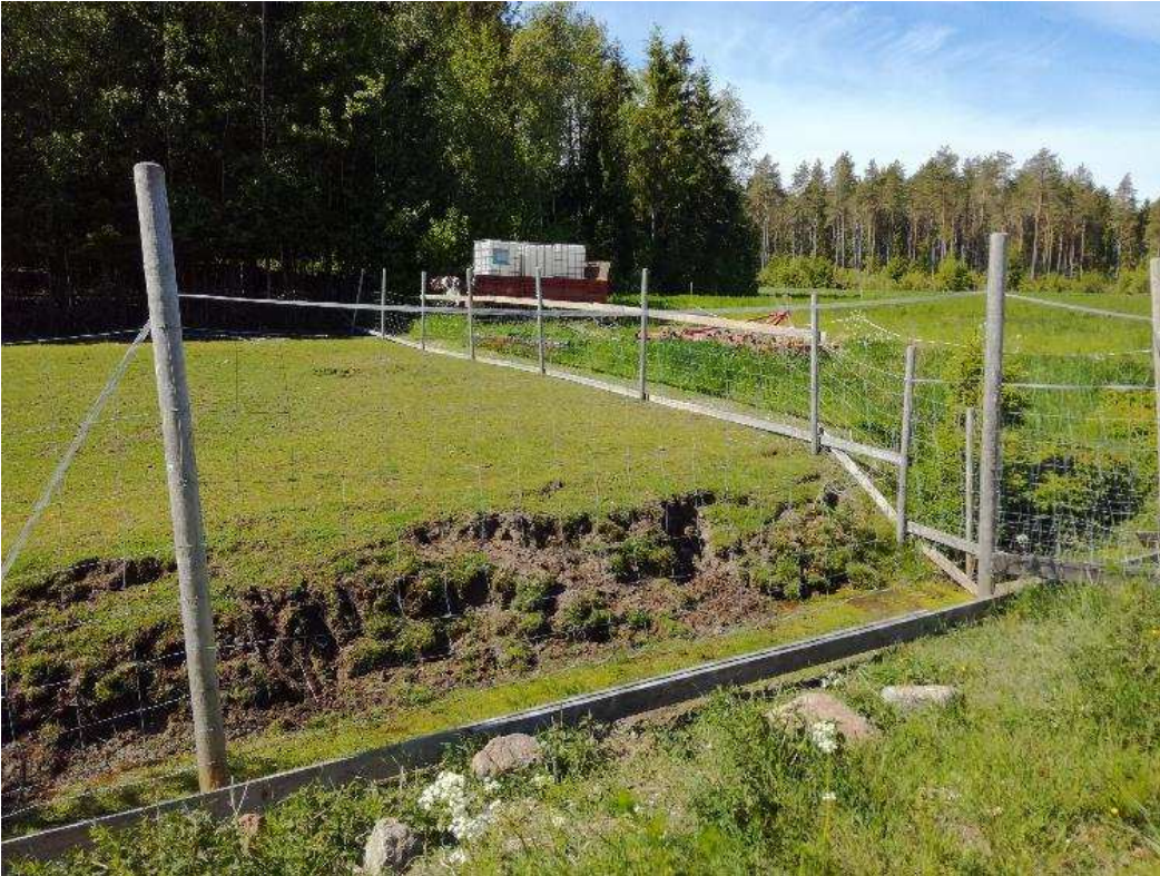
Kuva 11 Metalliverkko, voidaan täydentää laudoittamalla alareuna..
