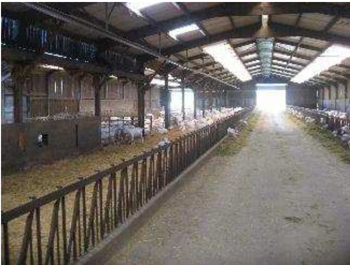
Kuva Lukkoparret. Korkea betoniseinä, jonka päällä ikkunat ja ilmanvaihto harvalaudoitus.
