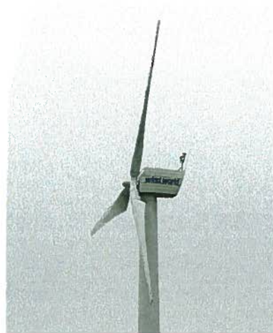
Kivistön voimala tuottaa 100 000 – 140 000 kWh/v.
