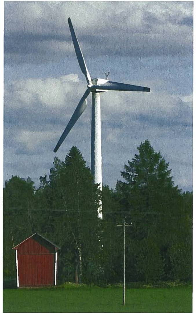
Kivistön voimala pyörii Jalasjärvellä kolmostien varrella.
