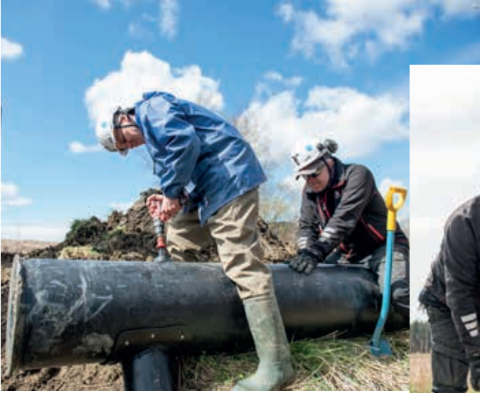
Projektipäällikkö Antti Kaseva ja kenttäestari Juha Niemi tekevät liitännöjä salaojavesien seurantaikaivon.
