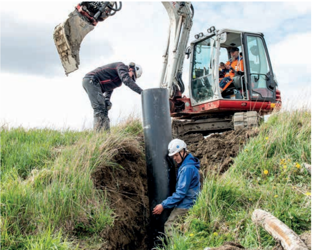
Projektipäällikkö Antti Kaseva ja kenttäestari Juha Niemi tekevät liitännöjä salaojavesien seurantaikaivon.
