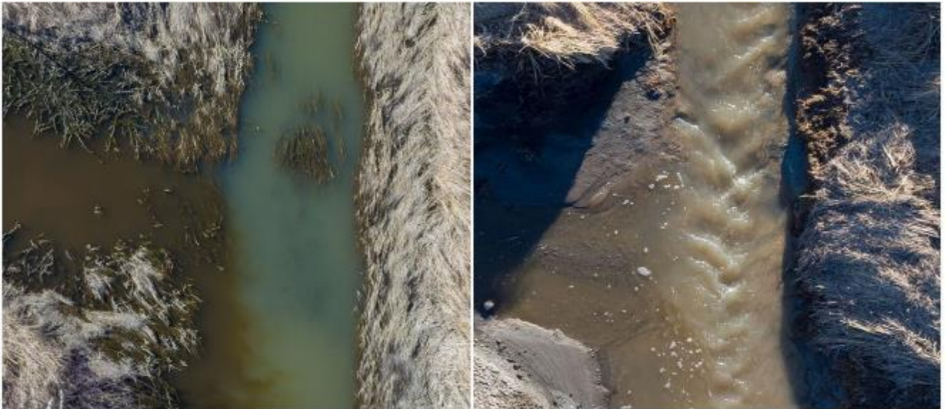
Kuva 8. Valtaojakunnostuksissa voidaan vähentää kiintoaineksen huuhtoumaa sekä pintavalunnan osalta että ojaan sedimentoituneen kiintoaineksen osalta. Ojaan kertynyt liete huuhtoutuu ylivirtaamien aikaan edelleen vesistöihin. Kuvassa veden sameus ennen kunnostustoimenpidettä vasemmalla ja toimenpiteen jälkeen oikealla. Etelä-Suomen Salaojakeskus.
