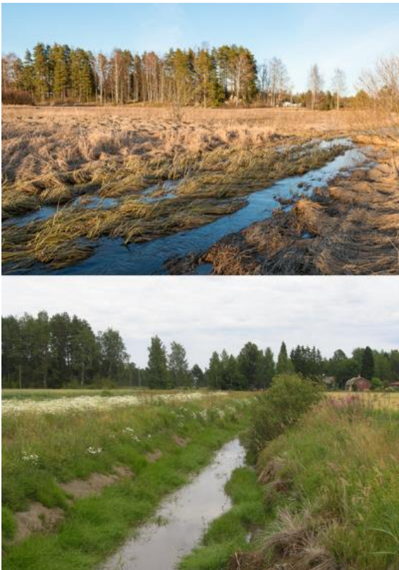
Kuva 4. Hardombäckenin valtaojauoma ennen kunnostusta ja kunnostuksen jälkeen Loviisassa. Perinteisen kaivun kustannukset olivat 3,5€/m alv. 0%. Kunnostuksella vähennettiin märkydestä johtuvia ongelmia 60-80 hehtaarin alueella. Kohde edustaa tyypillistä tilannetta Etelä-Suomessa. Ojauomasto on perattu kokonaisuudessaan viimeksi 60-luvulla. Ojaa on tästä lähin kunnostettu pätkittäin yksittäisten maanomistajien toimesta. Etelä-Suomen Salaojakeskus.
