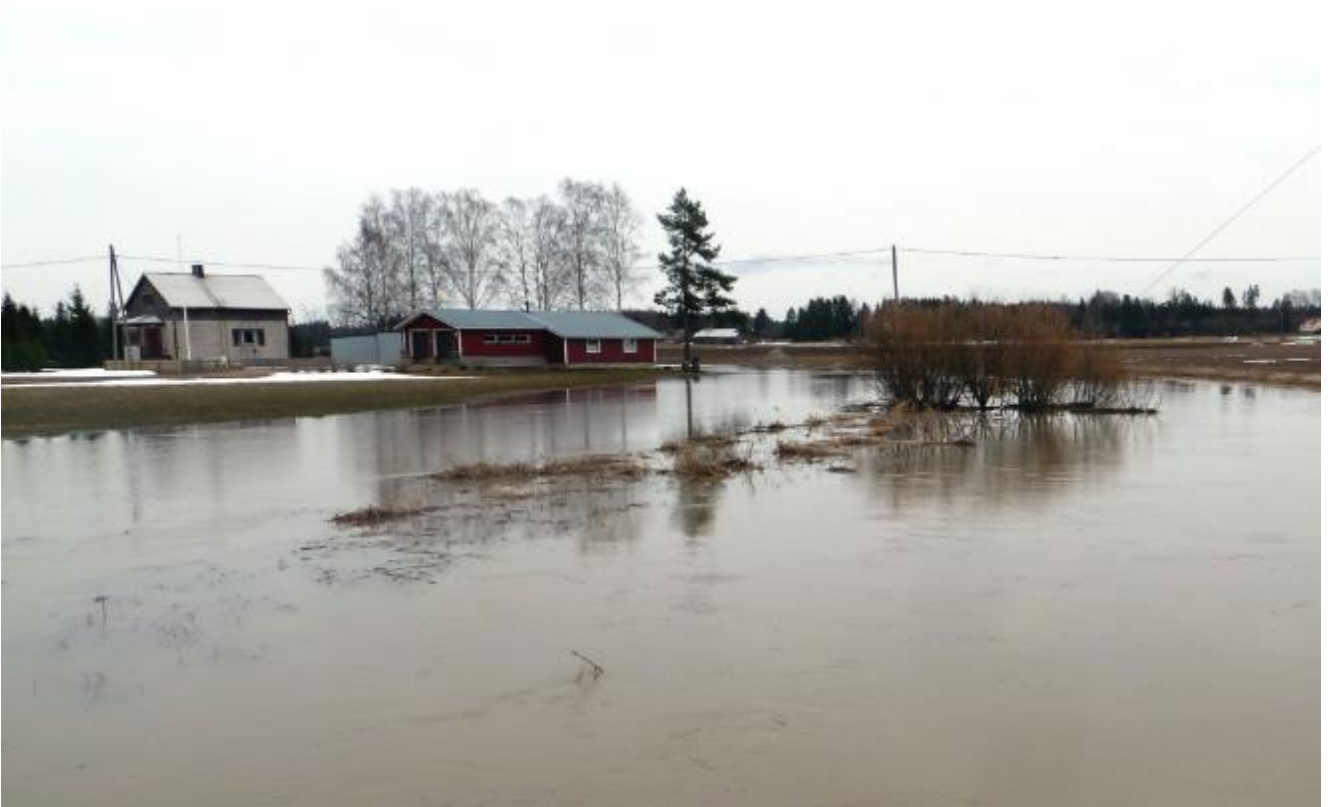
Kuva 7. Tulvavesi uhkaa asuin- ja tuotantorakennuksia Loviisanjoella. Etelä-Suomen Salaojakeskus.
