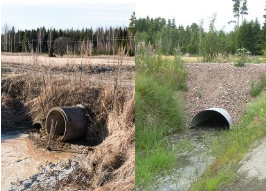
Kuva 13. Hardombäckenillä Loviisassa kunnostettiin rumpurakenteita ja veden pinta laski parhaimmillaan noin metrin. Kuvat ennen (vasemmalla) ja jälkeen kunnostuksen (oikealla). Etelä-Suomen Salaojakeskus.
