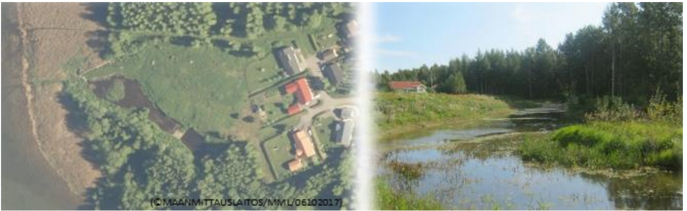
Kuva 17. Kuva pienestä joutomaa-alueelle rakennetusta monivaikutteisesta kosteikosta Äkeenojalla Asikkalassa asuinalueen ja Vesijärven rannan tuntumassa . Maanmittauslaitos / Mikko Ortamala.
