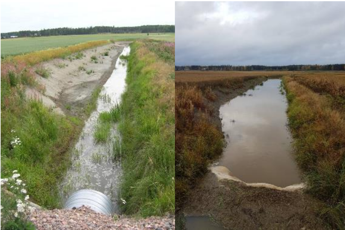
Kuva 10. Hardombäckenin toispuoleinen tulvatasanne 15\text{€}/\text{mtr} \cdot 300\text{mtr} = 4500\text{€} alv. 0% Kuvat kaivun jälkeen. Vesi ei noussut kunnostuksen jälkeen enää pellolle edes vuoden 2017 huipputulvalla. Etelä-Suomen Salaojakeskus.
