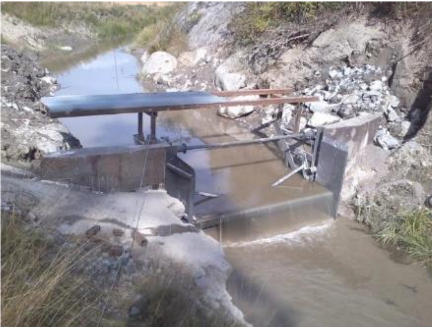
Kuva 15. Rakennettu kiinteä pohjapatorakenne Pohjalanjärven ojitussyhteisön uomassa sastamalassa, jossa voidaan kuitenkin säätökorkeutta muuttaa virtaamien sekä vuodenaikojen vaihtelujen mukaan. Etelä-Suomen Salaojakeskus.
