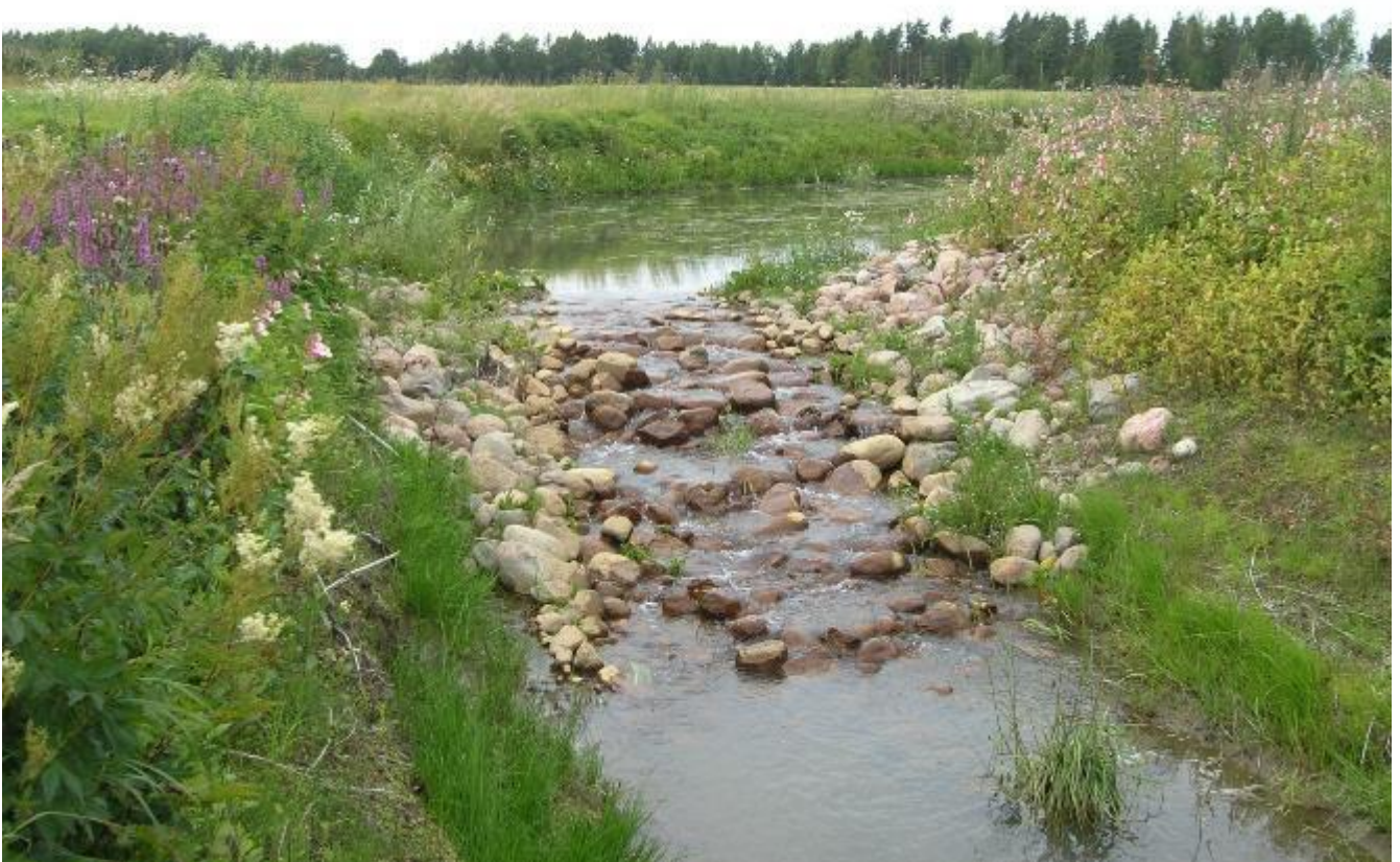
Kuva 18. Kokonaisvaltainen toimintatapa sisältää myös luonto- ja maisema-arvojen huomioimisen. Mahdollinen lohikalan kulku on huomioitu osana Hardombäckenin ojauomaston kunnostusta suunnitteluvaiheessa. 60-luvulla paljaaksi valtaojaksi peratun luonteensa vuoksi varsinaista virtavesikunnostusta ei ollut mahdollista tällä kohteella toteuttaa. Pohjapatorakenteet muodostettiin porrasmaisiksi lohikalojen mahdollista nousua ajatellen. Etelä-Suomen Salaojakeskus.
