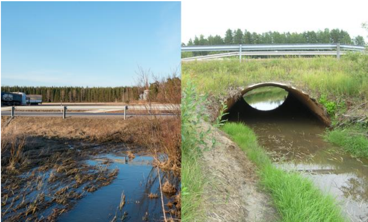
Kuva 6. Peruskuivatuksesta huolehtiminen vaikuttaa myös tierakenteiden ja rakennusten kunnossapitoon. Kuvassa Loviisan ja Lapinjärven välisen tien siltarumpu ennen kunnostustoimia ja kunnostustoimien jälkeen. Ojan vesipinta laski kunnostuksen myötä 1.2m. Etelä-Suomen Salaojakeskus.
