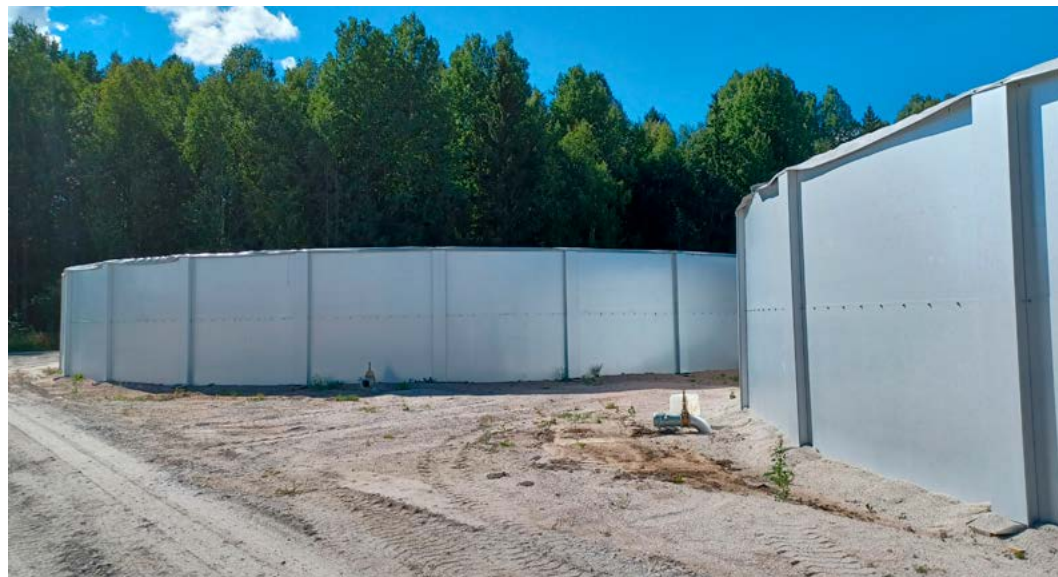
Siirrettävä lietesäiliö on hyvä ratkaisu kierrätyslannoitteiden varastointiin ja se toimii hyvin myös etäsäiliönä pellon reunalle pystytettynä. Kuva rakennusvaiheesta.
