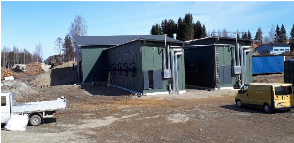
Kuva 2. Laitoksen kahdelle vaakatasoisen, jatkuvatoimisen reaktorin rinnalla on tilavaraus vielä kahdelle lisäreaktorille.
